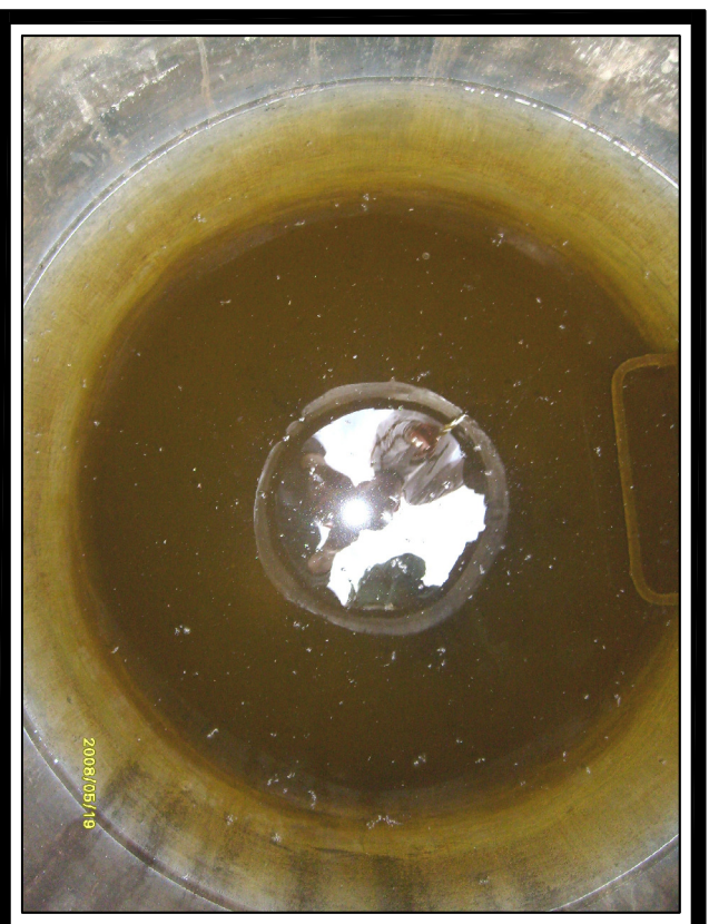
FOTO No. 2 Vista Interna de la Camara
