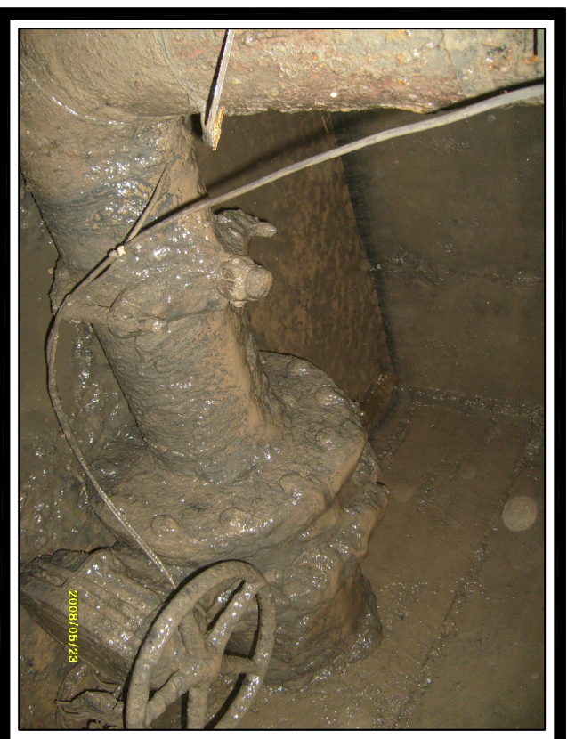
FOTO No. 2 Vista Interna de la Camara
