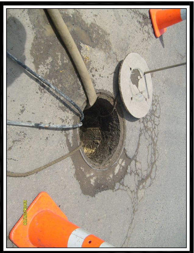
FOTO No. 1 Vista Externa de la Cámara
