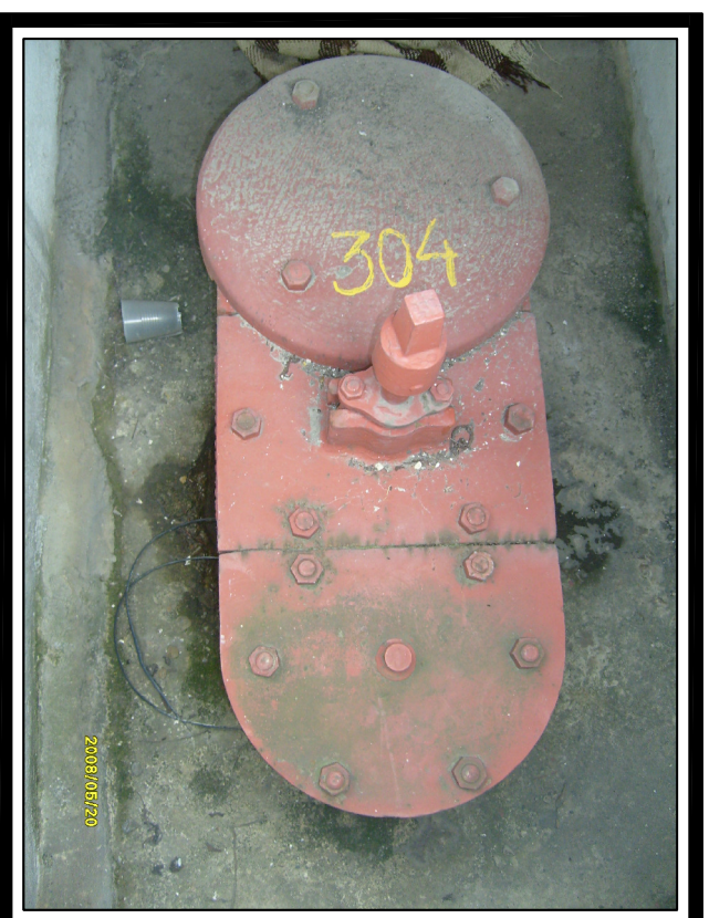
FOTO No. 2 Vista Interna de la Cámara
