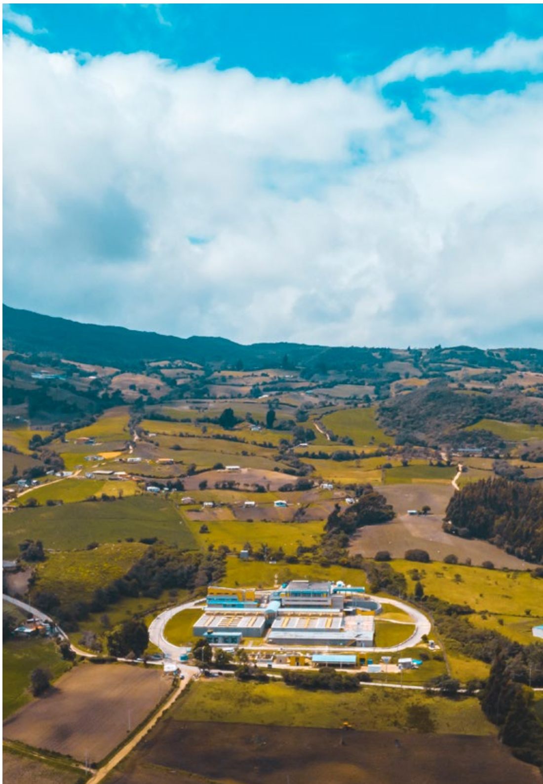
Planta de tratamiento de agua potable El Dorado. Foto: archivo EAAB.
