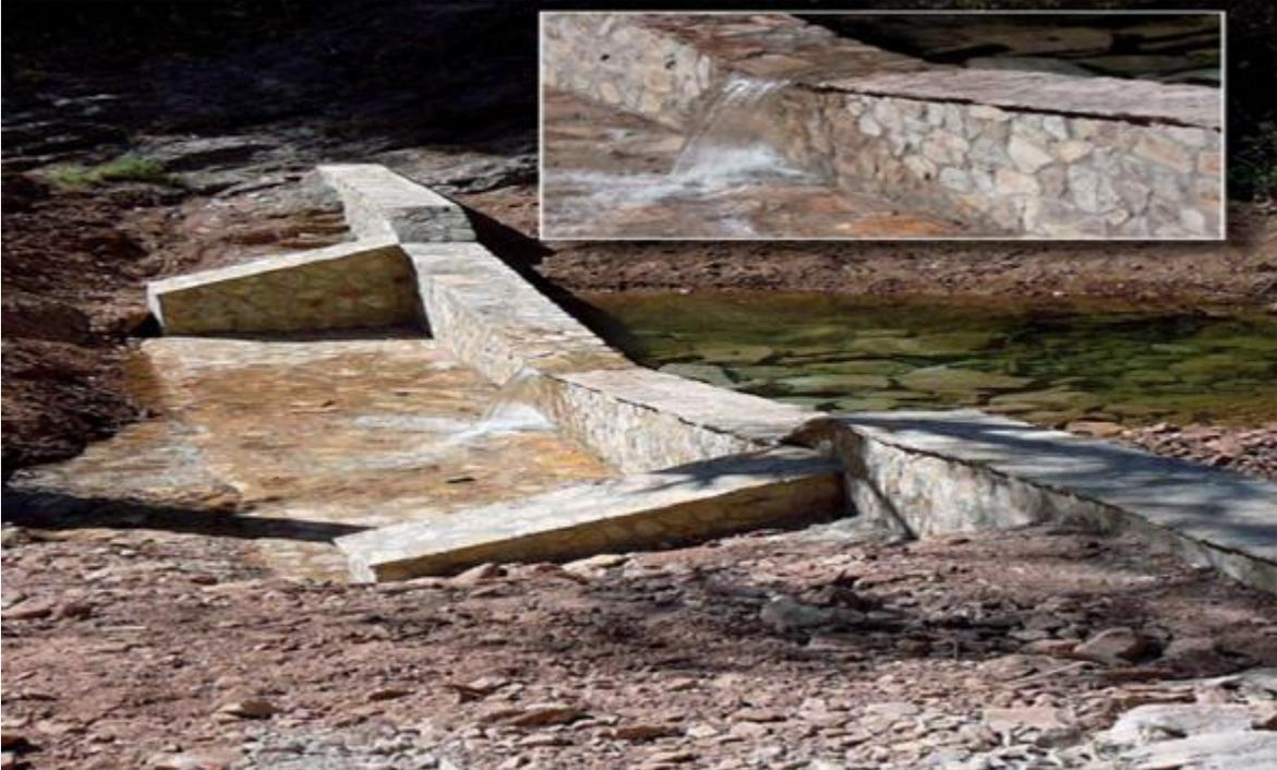
**Figura 15.** Vista de un dique de contención de cangrejo rojo aguas arriba en un arroyo del mediterráneo. Nótese que en la espalda del dique se han colocado acúmulos de piedras para que sirvan de refugio a los cangrejos que eventualmente puedan superarlo, facilitando con ello la localización y captura. Imagen tomada de Dana et al., 2011.
