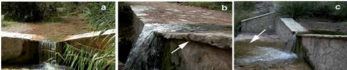
**Figura 14.** Detalles constructivos de los diques diseñados para contener eficazmente el avance del cangrejo rojo en el arroyo de la Fuensanta: a) forma de cuña para maximizar la velocidad del flujo y dificultar el avance aguas arriba; b) reborde saliente para impedir la escalada; c) suelo horizontal en la base del dique, que aumentan la exposición al aire y la depredación. Imagen tomada de Dana et al., 2011.
