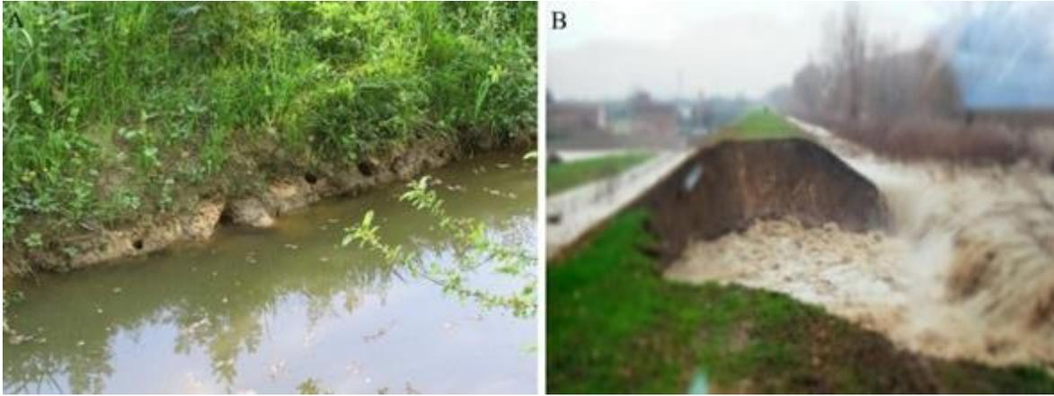
**Figura 12. A.** Madrigueras construidas por *P. clarkii* en acequias de riego; **B.** Dique roto junto al río Secchia (Emilia Romana, Italia) debido a la actividad excavadora del cangrejo rojo americano. Imagen tomada de Haubrock et al., 2019.
