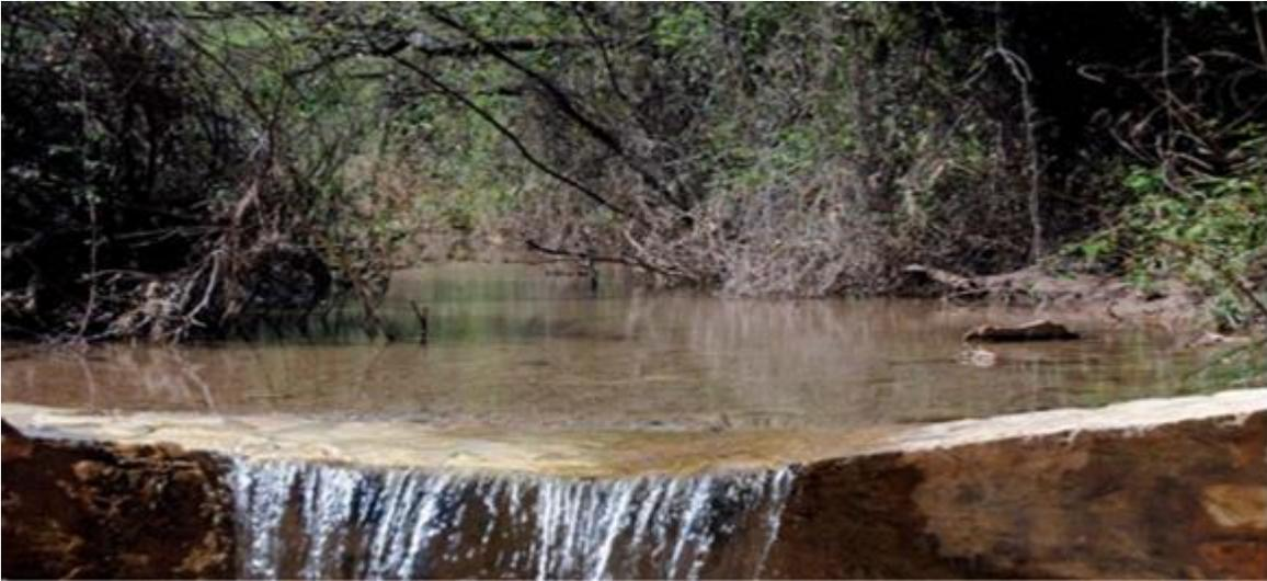
**Figura 13.** Vista de uno de los diques de contención de cangrejo rojo, diseñados para minimizar sus efectos sobre la dinámica fluvial y contener eficazmente el ascenso aguas arriba de los cangrejos rojos invasores (*Procambarus clarkii*). Imagen tomada del libro *Manual de Gestión de Cangrejos exóticos invasores*
