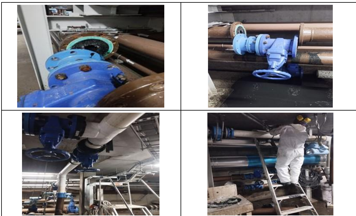
Fotografía 31. Mantenimiento tubería de centrífuga 073SC002A
