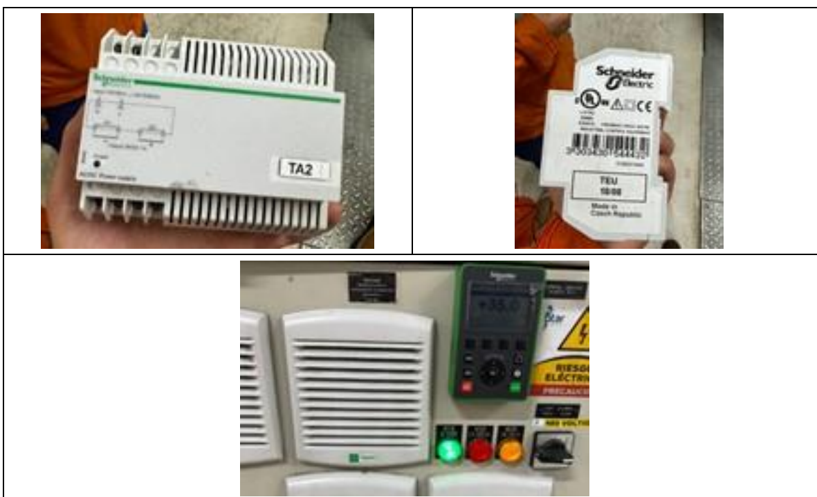
Fotografía 4. Mantenimiento bomba de lodos a espesadores de banda por gravedad 090P101D
