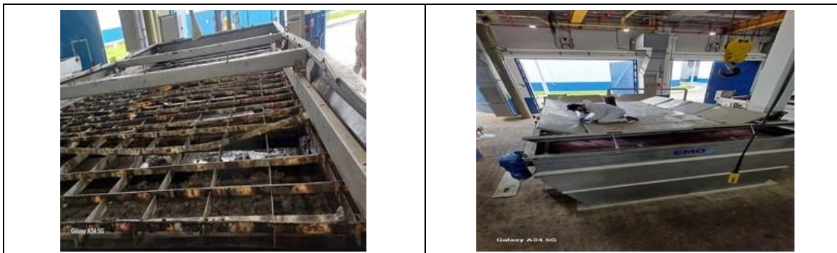
Fotografía 35. Mantenimiento mesa espesadora 076DEP001G
