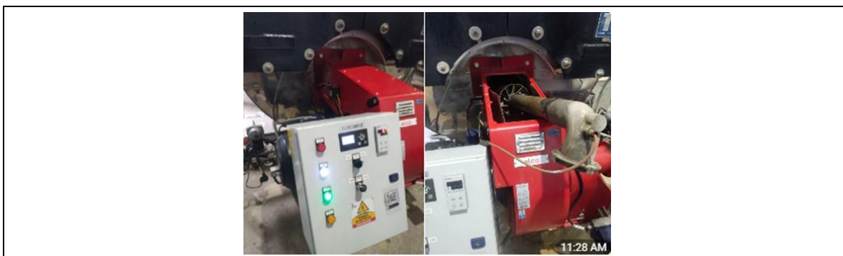
Fotografía 29. Mantenimiento caldera 111ECA001E
