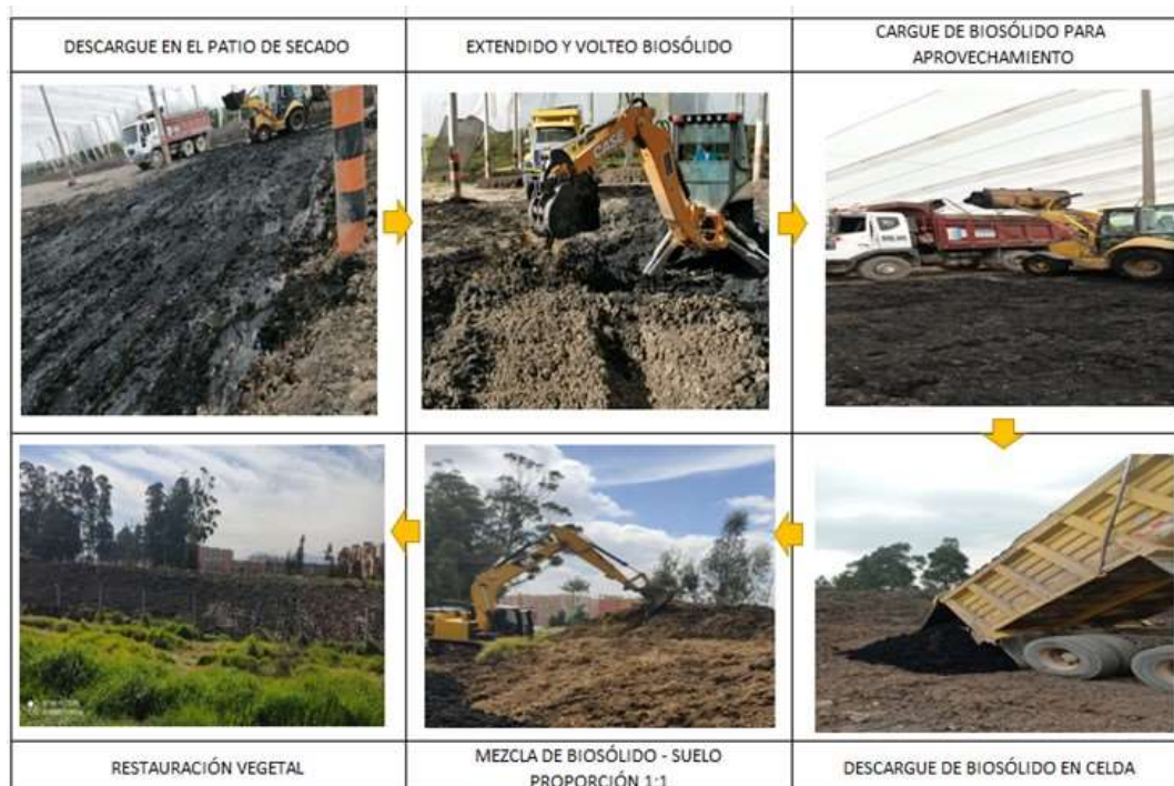
Imagen 3.2-5 Actividades para el aprovechamiento del e Biosólido, predio el Corzo y la Magdalena
