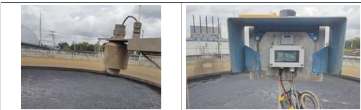
Fotografía 14. Cambio medida del sensor ultrasónico
