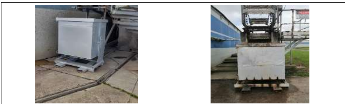
Fotografía 7. Contenedor ubicado sobre caída de banda proveniente del cribado fino. (Recepción de sobrenadantes y arenas).
