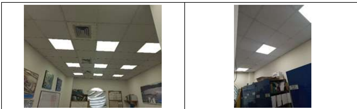
Fotografía 12. Cambio de iluminación
