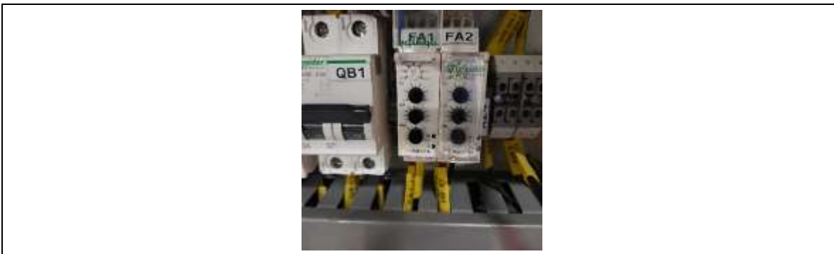
Fotografía 19. Mantenimiento tablero CCM-10
