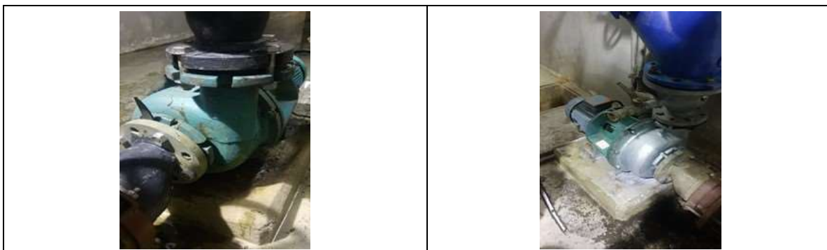
Fotografía 8. Reparación y montaje de la bomba de arenas
