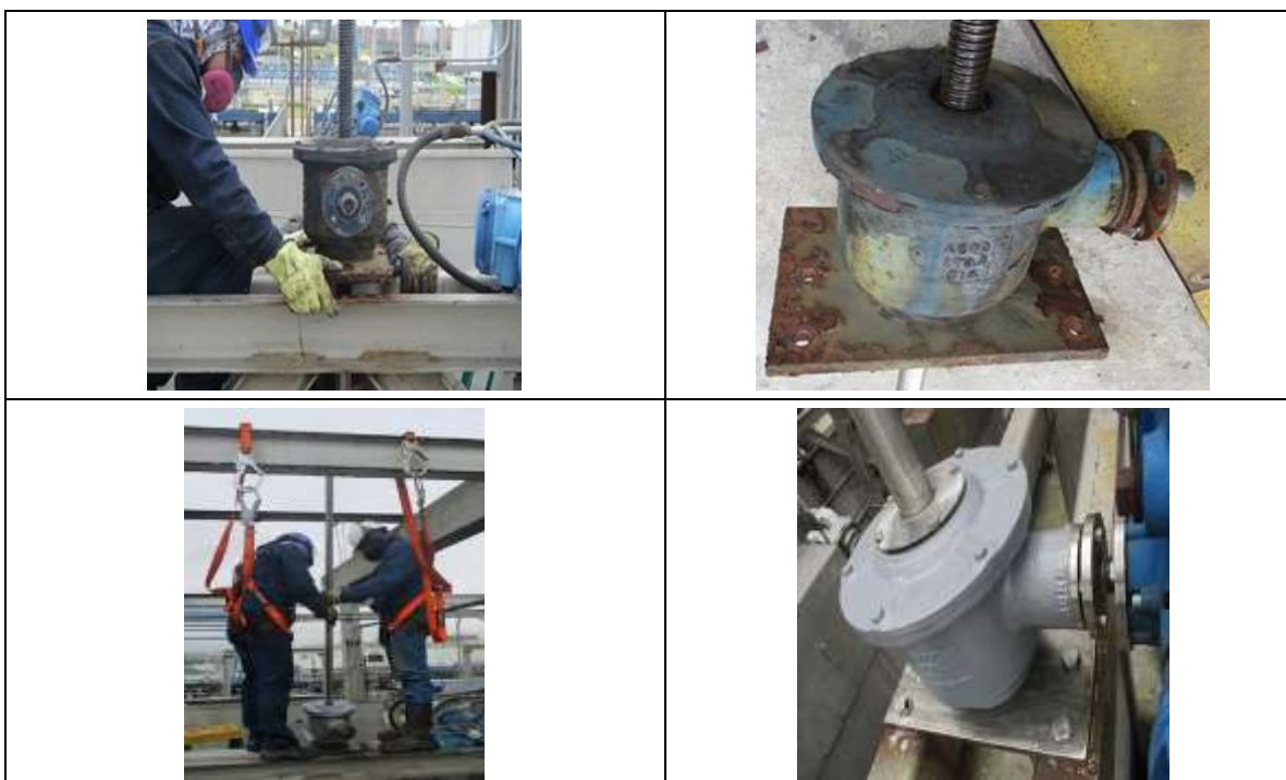
Fotografía 10. Mantenimiento compuertas by-pass canal salitre
