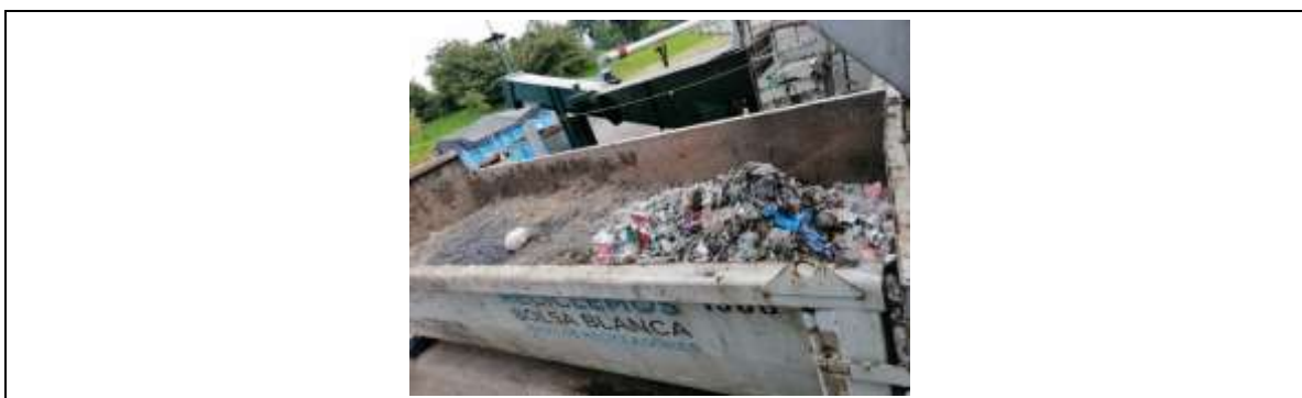
Fotografía 7. Contenedor ubicado sobre caída de banda proveniente del cribado fino. (Recepción de sobrenadantes y arenas).
