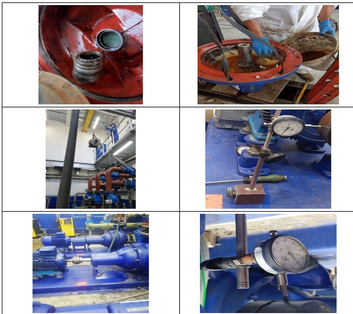
Fotografía 6.Manmtenimiento bomba lodos primários N°58.1 058P101B
