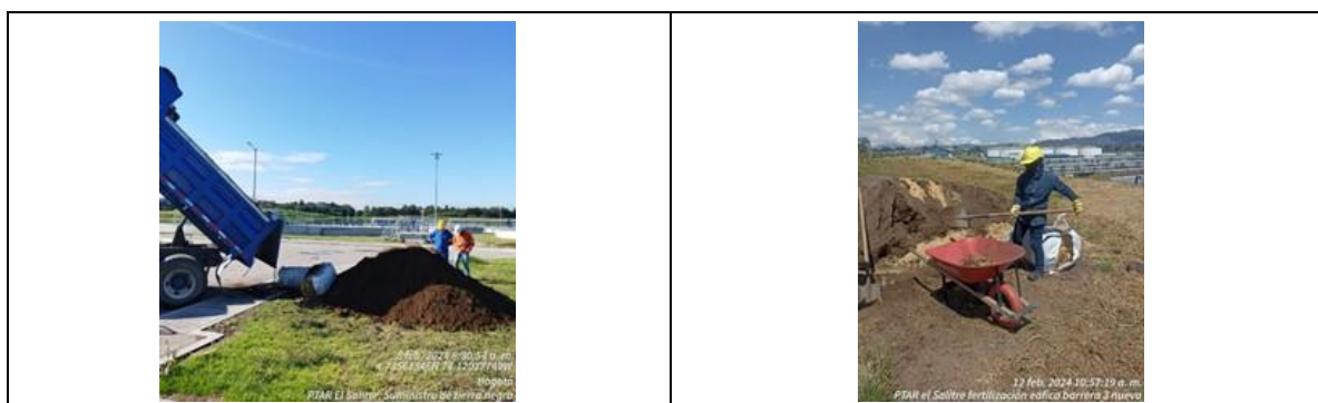
Fotografía 35. Suministro de tierra negra
