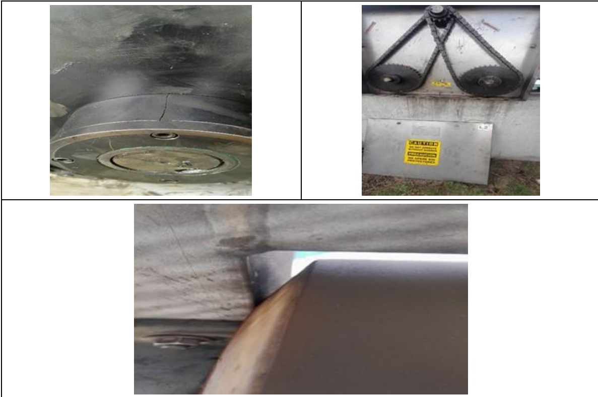
Fotografía 9. Mantenimiento clarificador secundario 061DCL001L
