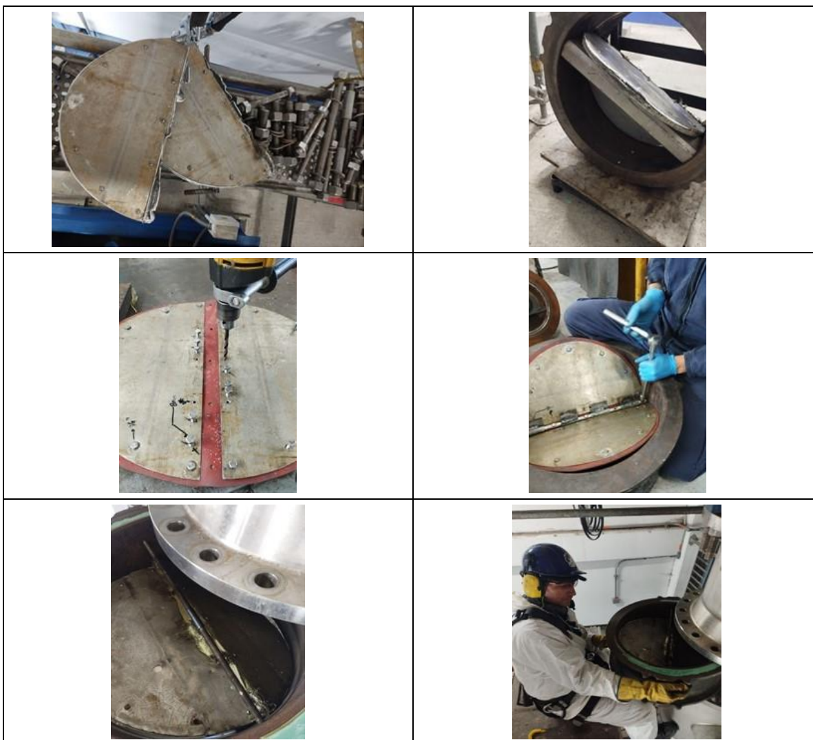
Fotografía 5. Mantenimiento soplante 061C001K
