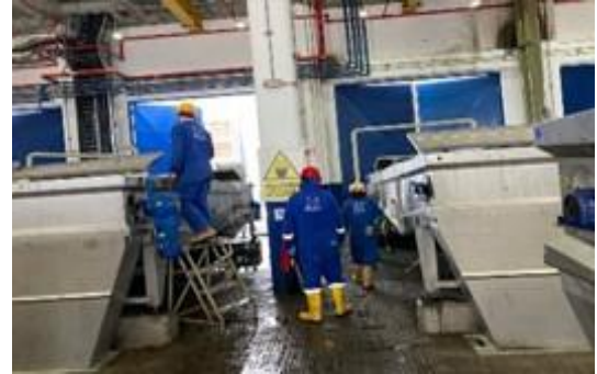
Supervisión de cumplimiento de Epp, en actividades de mantenimientos
