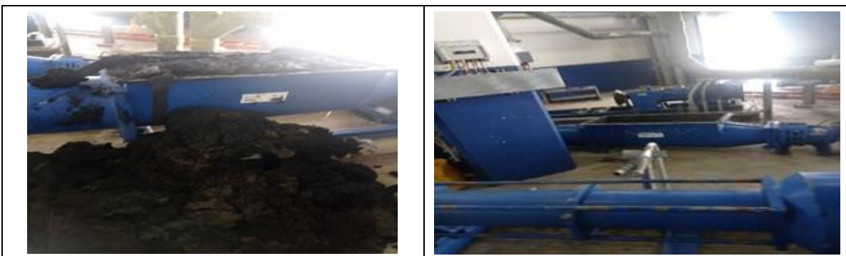
Fotografía 10. Mantenimiento bomba lodo deshidratado a silos 073P002A y B
