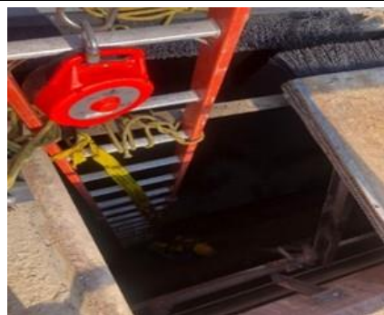
Acompañamiento en limpieza de desarenadores.
