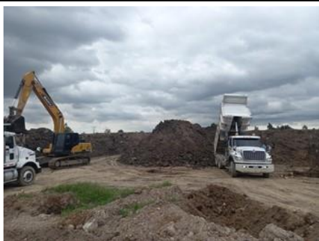
Descargue de biosólido en celda 13 La Magdalena, metodología 3:1
