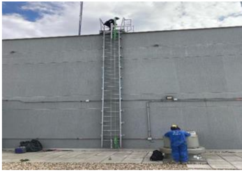
Mantenimiento correctivo a aires acondicionados de cogeneración
