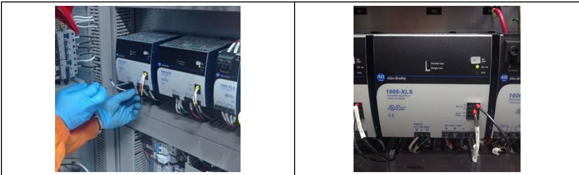
Fotografía 24. Cambio fuente Allen Bradley en tablero de control y temperatura de bombeo de agua cruda
