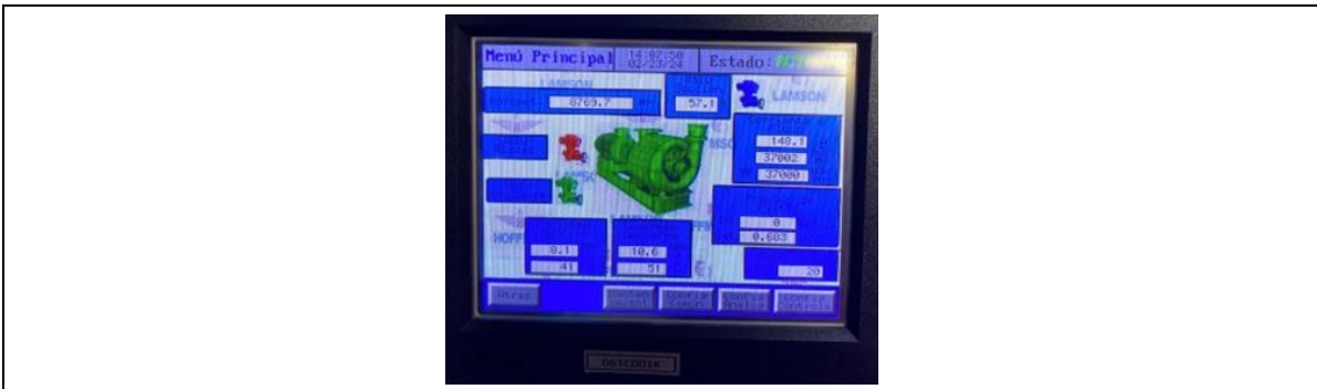
Fotografía 28. Mantenimiento soplante K
