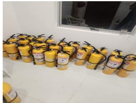
Rotulación de extintores
