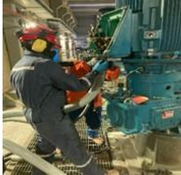
Mantenimiento correctivo a bomba de elevación en pretratamiento
