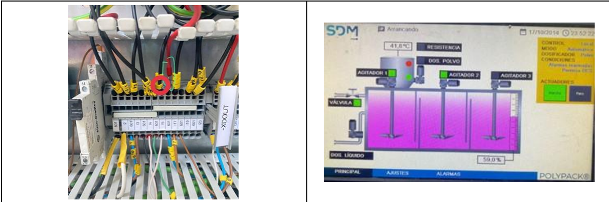
Fotografía 8. Mantenimiento skid de polímero 074QP201A
