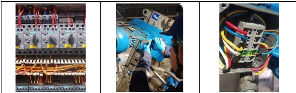
Fotografía 16. Mantenimiento reja automática en canal 051DGL002B
