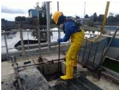
Inspección y seguimiento en el uso de E.P.P., actividades de limpieza de estructuras operativas de la PTAR
