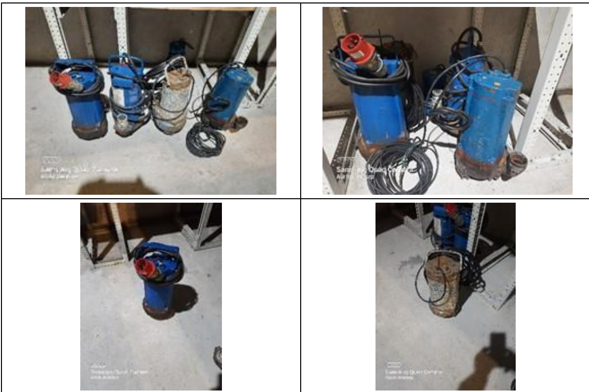
Fotografía 15. Mantenimiento bombas de achique
