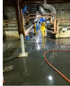
Limpieza del digestor por derrame
