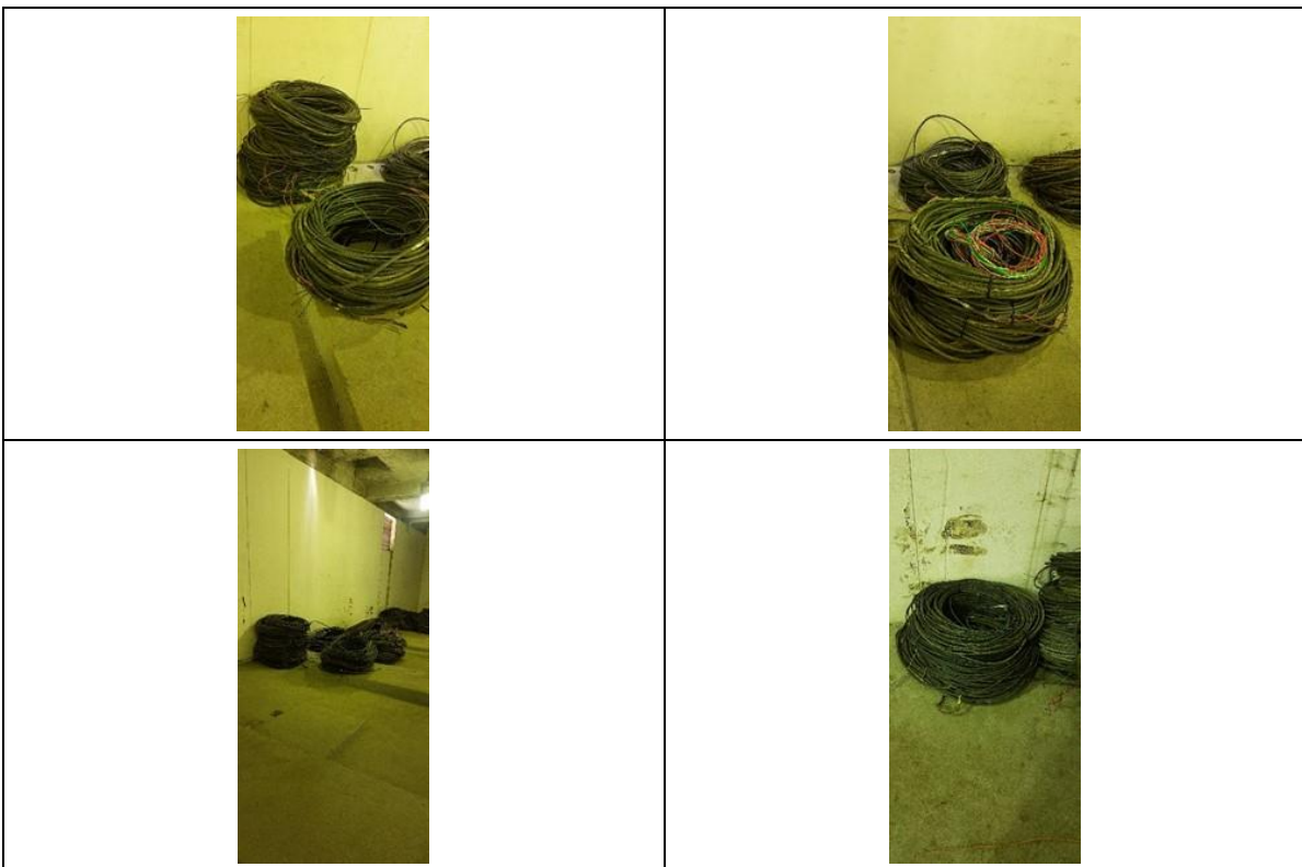
Fotografía 17. Recepción cableado calentamiento
