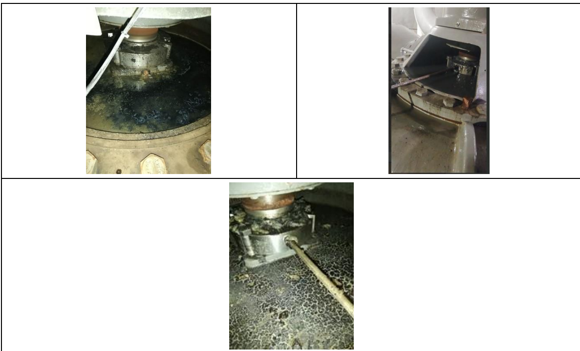
Fotografía 10. Mantenimiento bombas de elevación de agua cruda 053P002G y 053P002J
