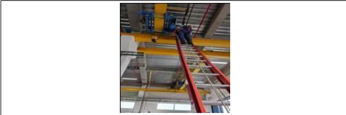
Fotografía 18. Mantenimiento puente grúa
