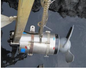
MANTENIMIENTO GITADOR DE LODOS C
