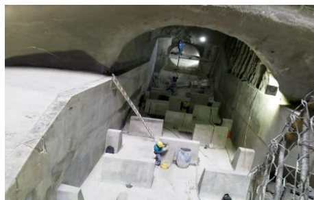
Municipio Soacha, Estructura de Conexión interceptor Tunjuelo Canoas con el túnel de descarga.
