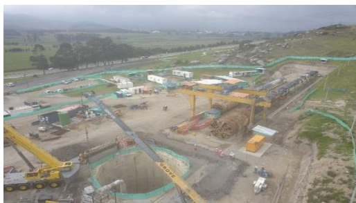
Municipio Soacha, Conexión Interceptor Tunjuelo Canoas Pozo 12
