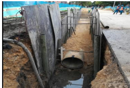
Figura 14. Construcción del by-pass de la estación de bombeo el recreo al interceptor fucha – tunjuelo.
