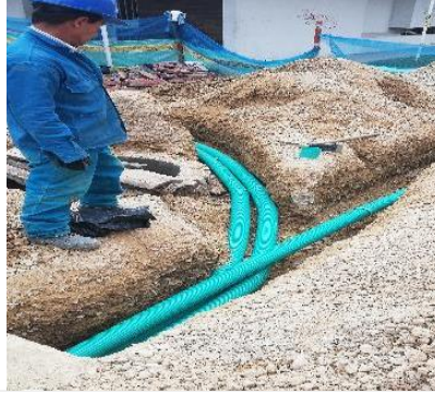
Figura 17. Recuperación de espacio público asociado a la rehabilitación integral del sistema de alcantarillado combinado sub cuenca colector calle 22
