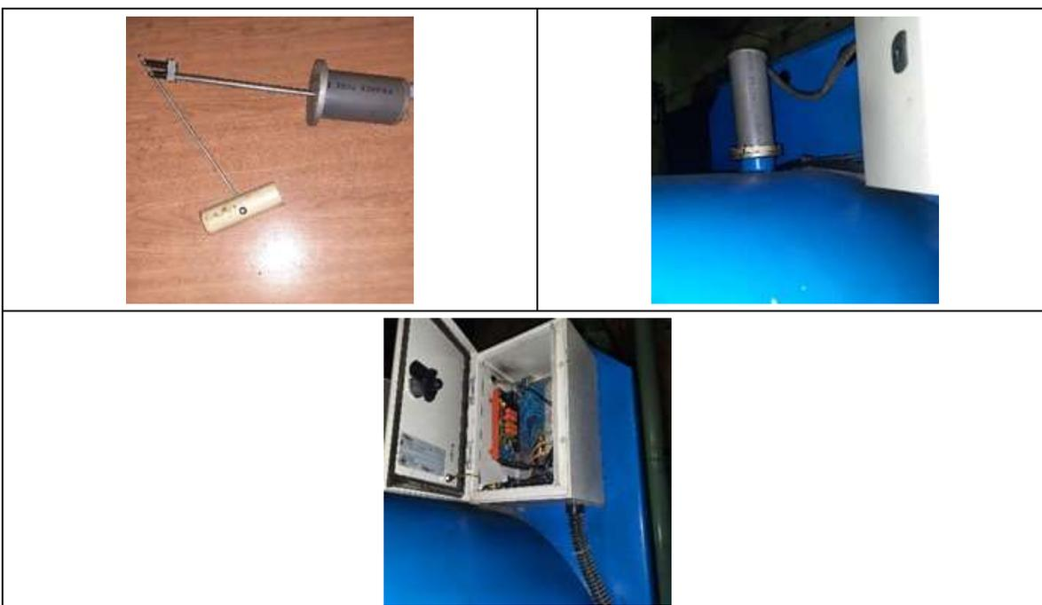
10. Cambio e instalación de dos bombas de achique por las existentes, con el fin de garantizar el bombeo de agua remanente dentro del edificio de pretratamiento, al mismo tiempo se verifican las acometidas e instalan nuevos ductos eléctricos para su correcta operación.
