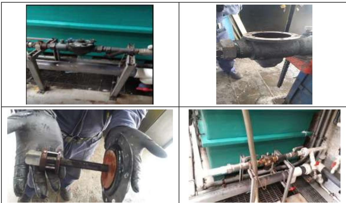
4. Se realiza mantenimiento preventivo a la caldera 010E01A, se realiza corrección de fallos, se encuentra incrustación de material, es necesario usar disco de grata con pulidora para realizar la limpieza, se realiza el armado y pruebas de funcionamiento. Todo esto para garantizar una operación de puesta en marcha en buenas condiciones
