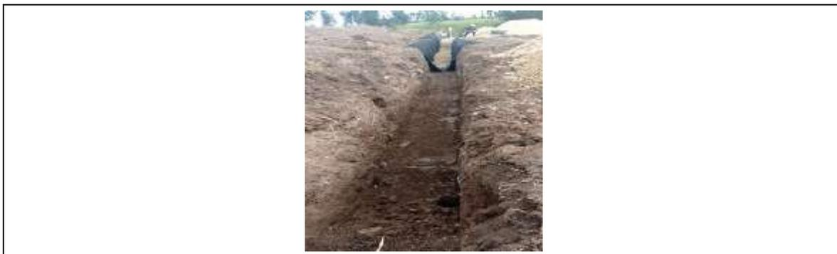
**Fotografía 3. Instalación de tubería tipo RIB DRAIN**
