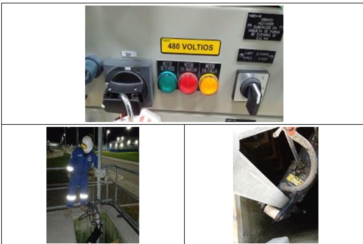
Fotografía 15. Mantenimiento agitador 108A0010
