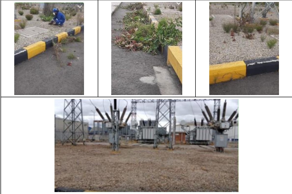
Fotografía 16. limpieza a la sub estación 115
