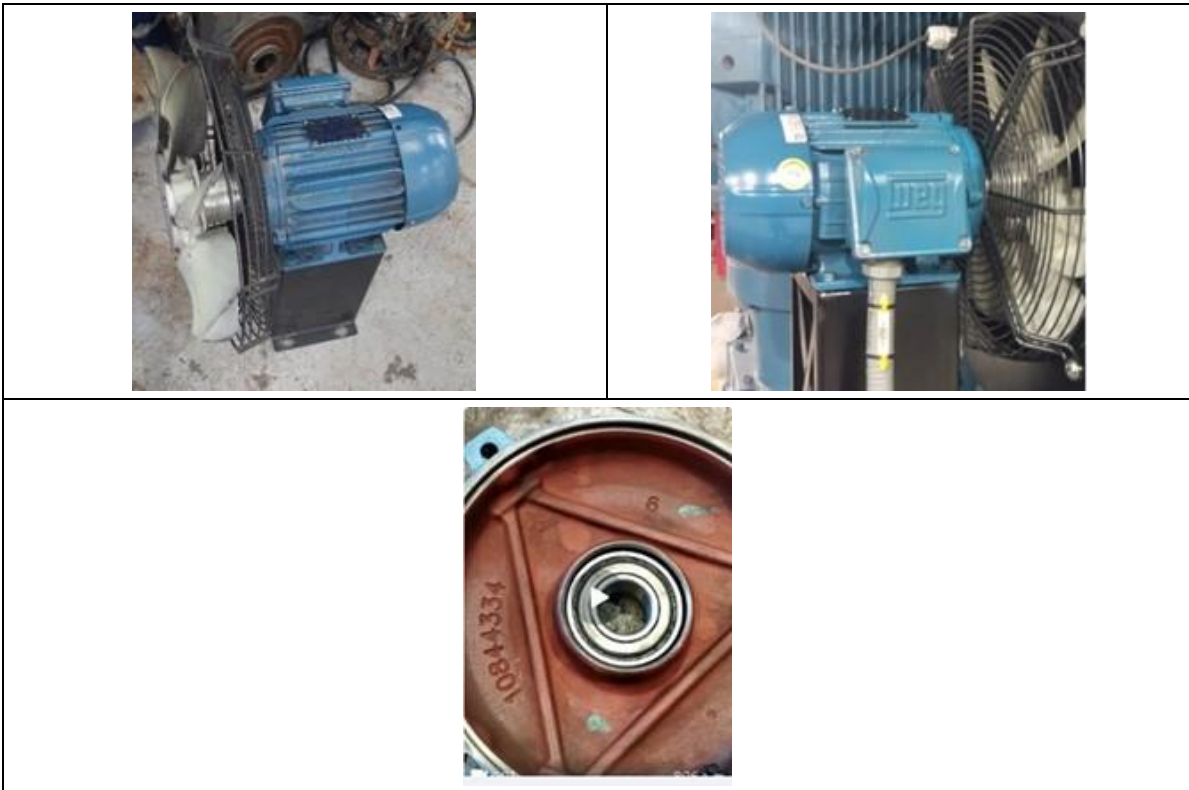
Fotografía 29. mantenimiento bomba de agua cruda 053P002J/G
