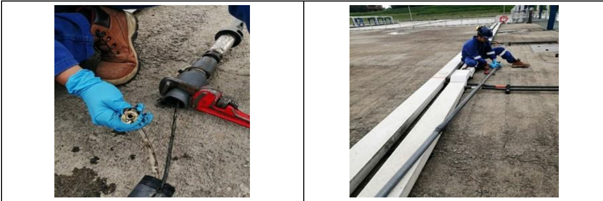
Fotografía 16. Mantenimiento sensor de oxígeno disuelto
