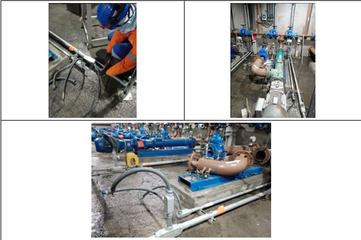
Fotografía 27. Adecuación tuberías montaje bomba 090P102A.
