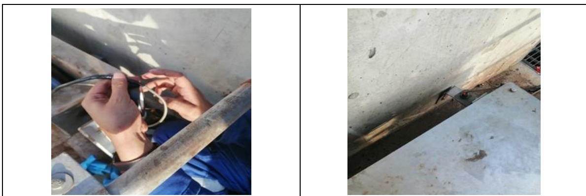
Fotografía 26. mantenimiento puente desarenador 54.5
