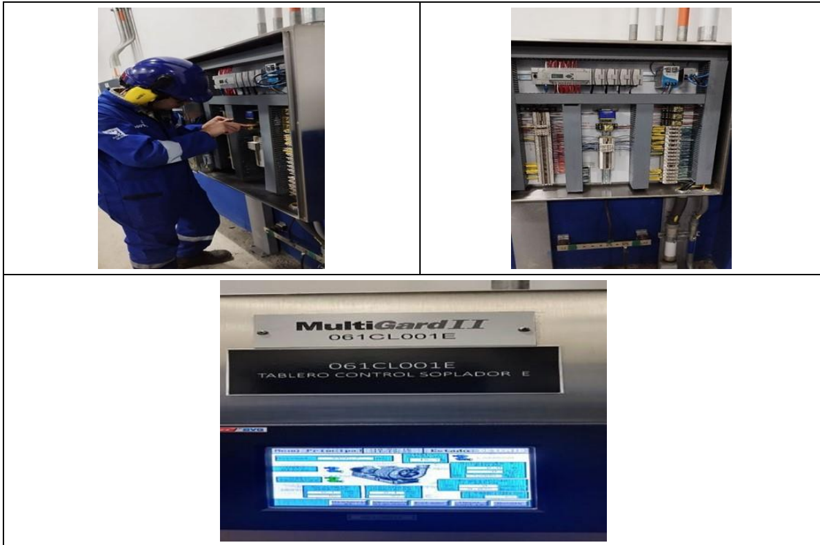
Fotografía 25. mantenimiento tablero de control local de soplante E/H/I/J
