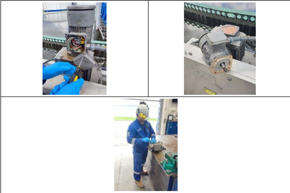
Fotografía 30. Mantenimiento motor de arrastre decantador secundario
