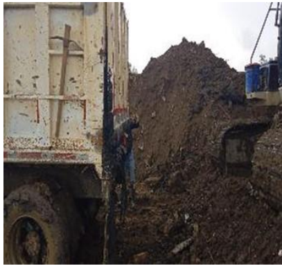
Descargue de biosólido en celda 7 Magdalena, metodología 3:1
