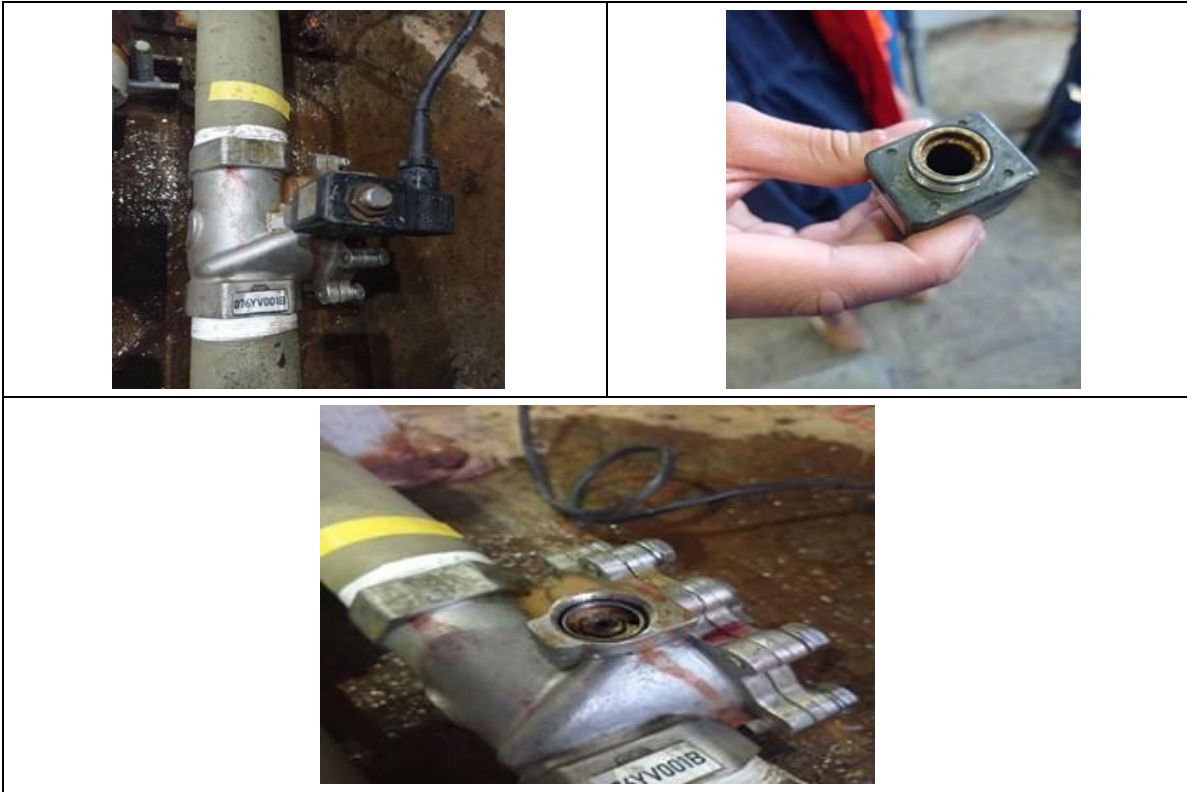
Fotografía 14. Mantenimiento electroválvula 076YV001D
