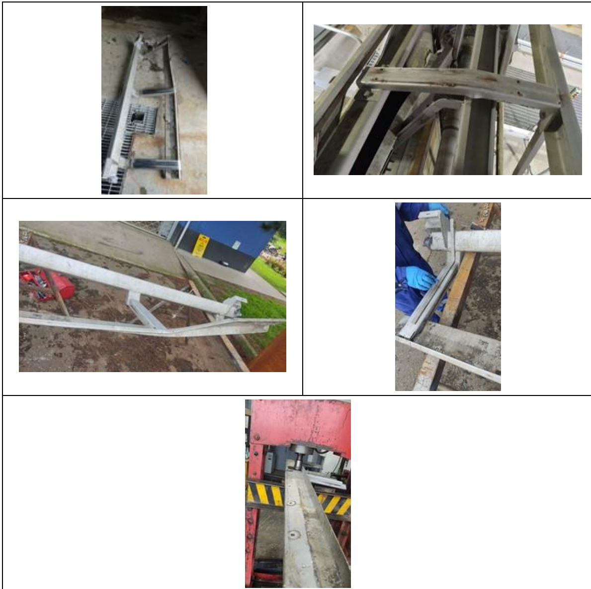
Fotografía 13. Mantenimiento rejas 051DGL001A/B/H
