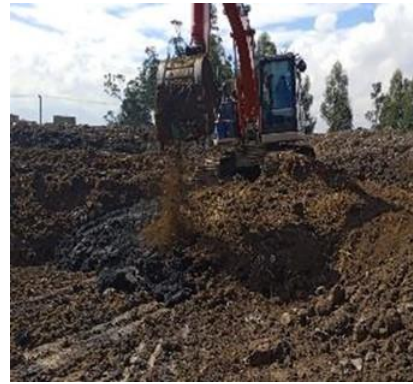
Labores de mezcla Aprovechamiento predio la Magdalena celda 7A, metodología 3:1
