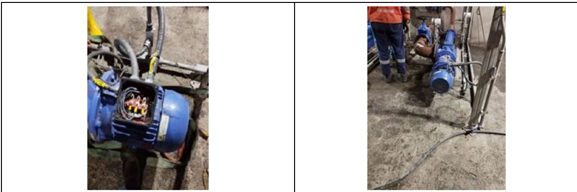
Fotografía 28. Traslado bombas 090P102C
