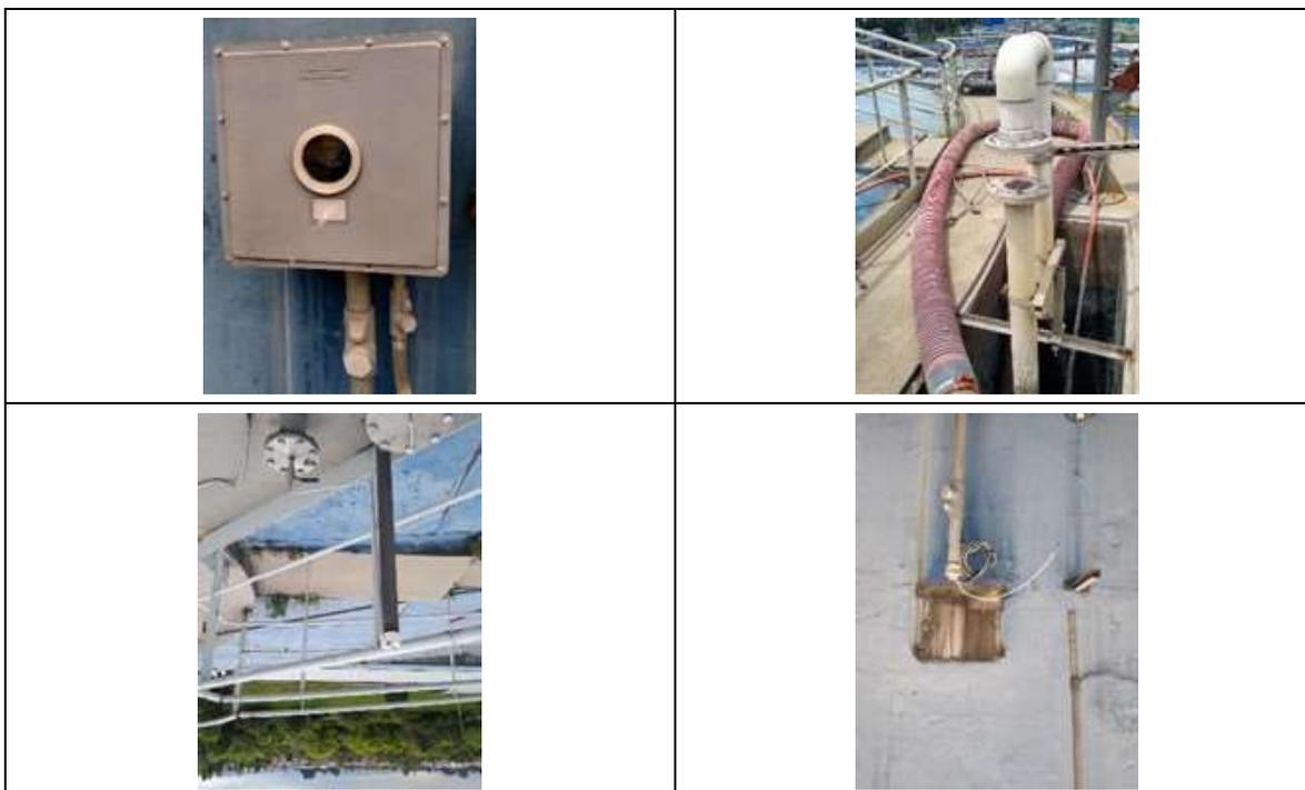
7. Cambio de tableros de mando local para las bombas de arena y grasas de las galerías, Debido a deterioro de las cajas por el ambiente corrosivo al igual que algunos circuitos eléctricos fueron cambiados. Para dejarlos en perfectas condiciones de funcionamiento.
