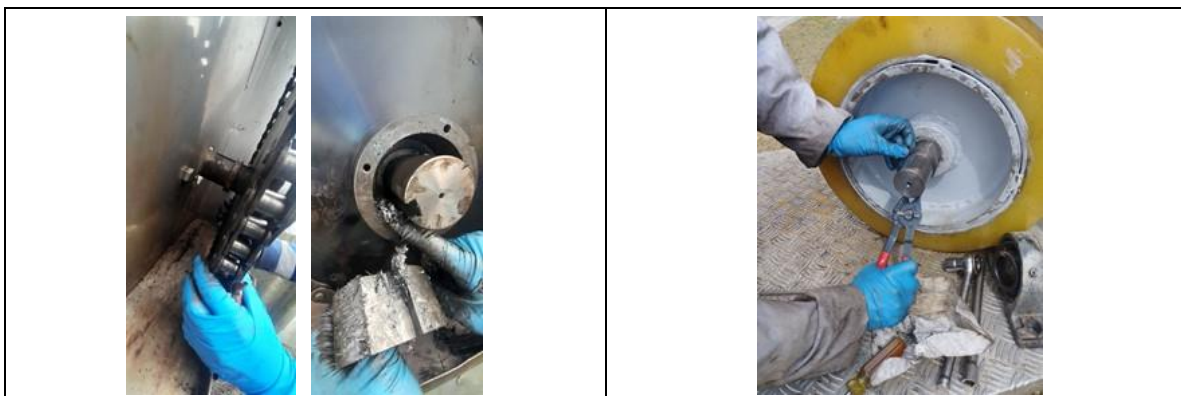
Fotografía 4. Mantenimiento puentes clarificadores secundarios
