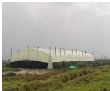
Vista general de la cubierta de secado
