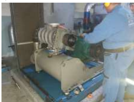
Instalación de correas y alineación de poleas
