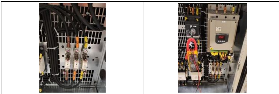
Fotografía 3. Mantenimiento Bomba Vaciado Deshidratación 095P201C
