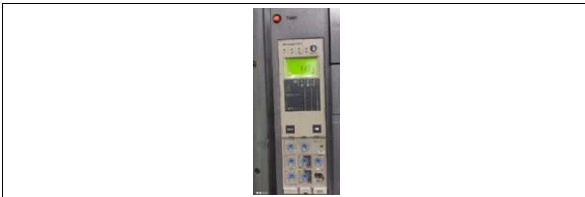
Fotografía 4. Mantenimiento MasterPact lado B CCM9
