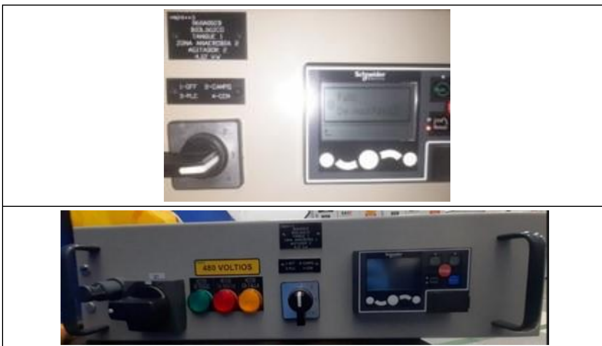
Fotografía 5. Mantenimiento agitador sumergible 060A002B
