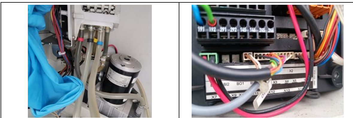
Fotografía 11. Mantenimiento tomador de muestra de agua cruda
