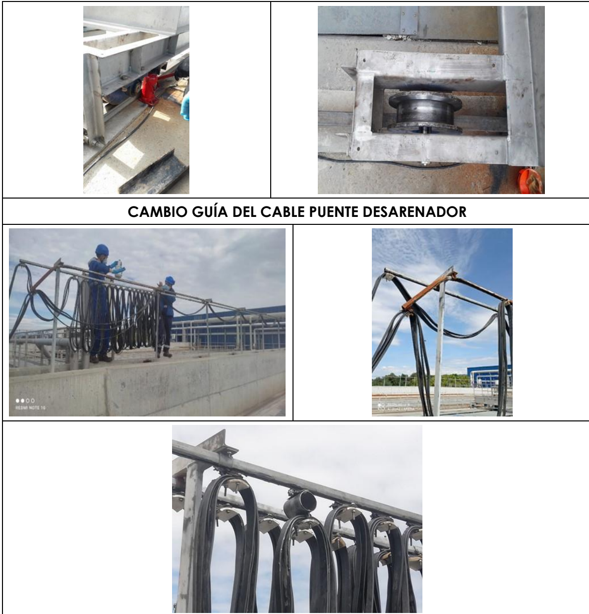
Fotografía 11. Mantenimiento puentes desarenadores PTAR fase II
