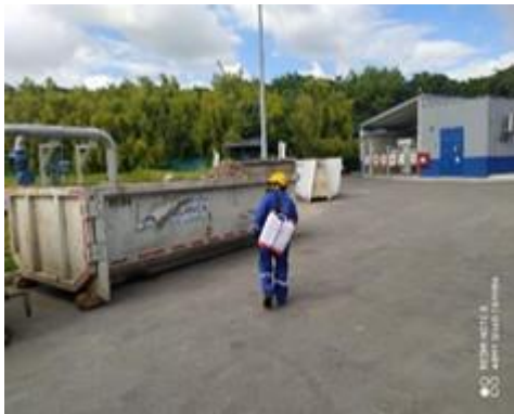
Fumigación de volcos con material de rejas finas y rejas gruesas, para evitar olores ofensivos.
