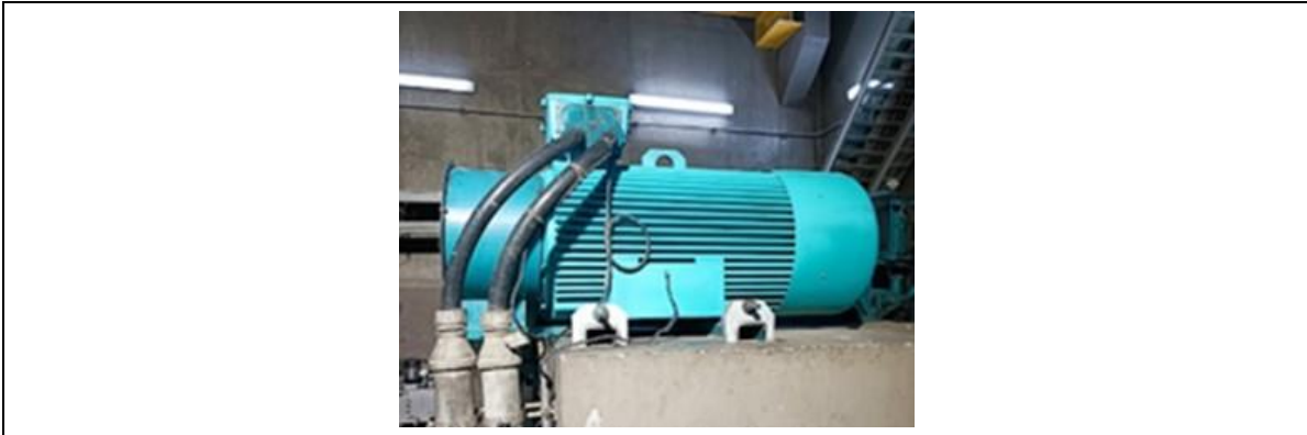
Fotografía 9. Mantenimiento tornillo de elevación de agua cruda 01P01A
