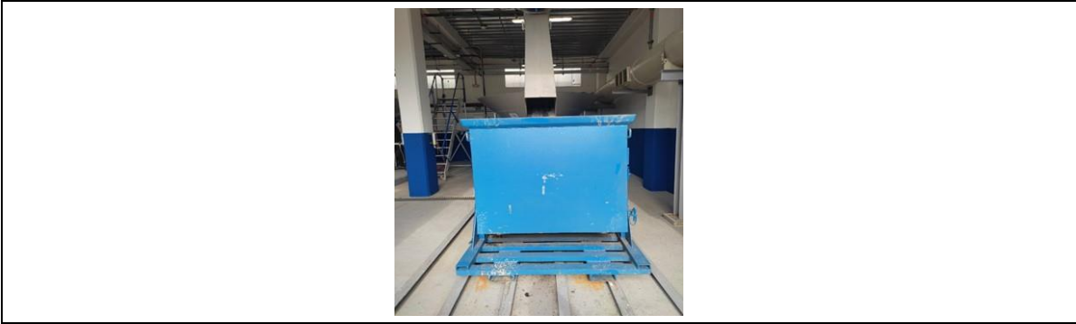
Fotografía 6. Residuos de pretratamiento provenientes del descargue de contenedores del material cribado resultante de Gruesos y Finos.
