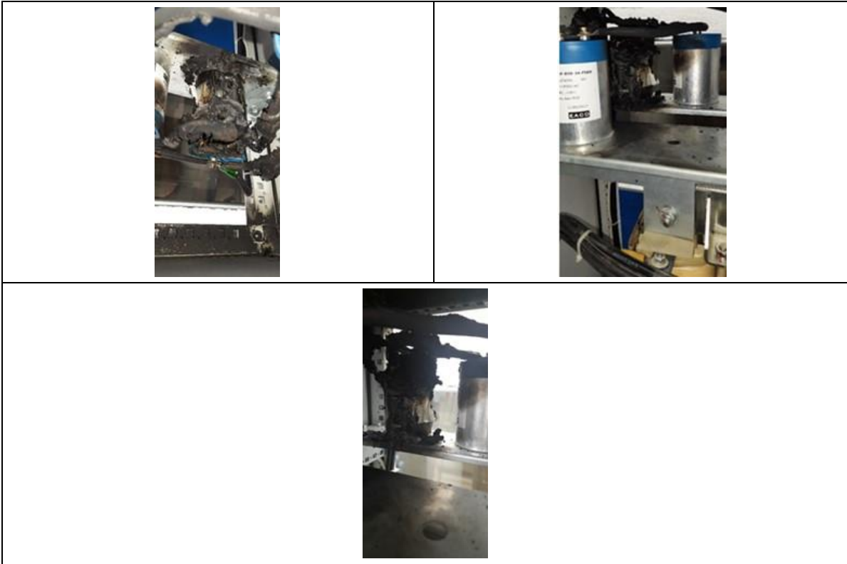
Fotografía 15. Falla variador PTAR fase II
