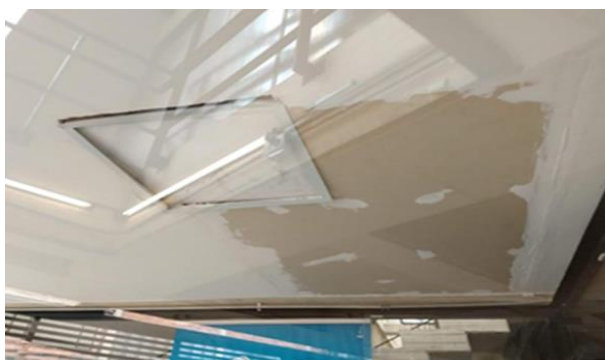
Fotografía 9: Cielo raso (drywall) sin acabado en área de recepción Fuente: Equipo auditor
