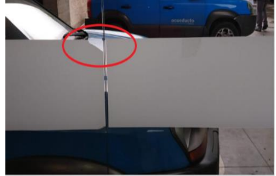
Fotografía 2: Deficiente calidad cintas sandblasting Equipo auditor
