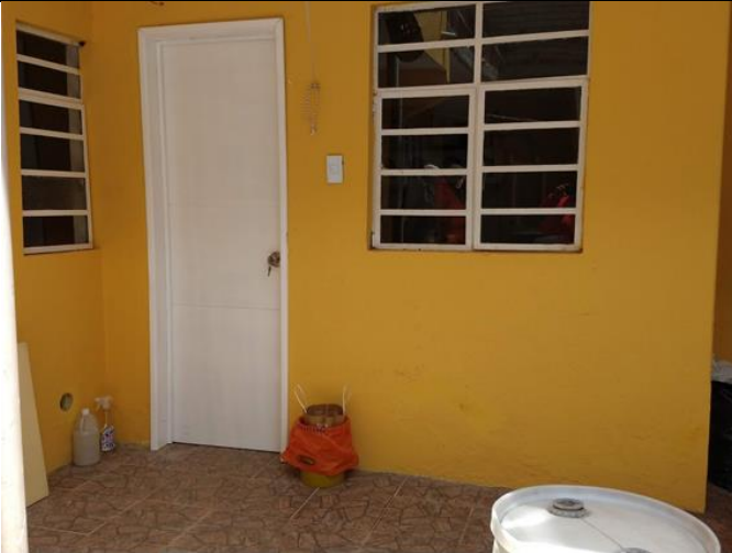
Fotografía: Reparaciones en vivienda afectada por inundación en desarrollo de contrato No. 1-01-34100-01061-2016 Fuente: Equipo Auditor
