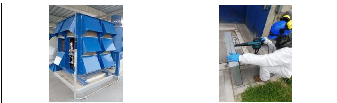
Fotografía 11. Instalación transmisión de presión 053PIT002J
