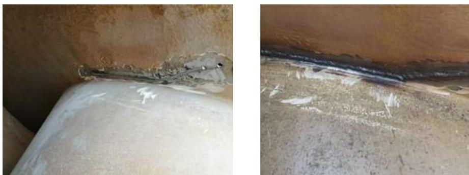
Preparación de superficie "fisura" Soldadura SMAW E 6010 - E7018
