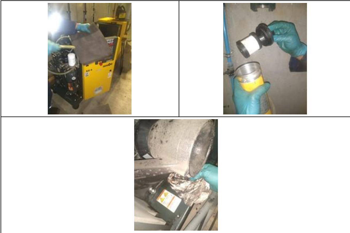
Fotografía 11. Mantenimiento preventivo compresores KAESER
