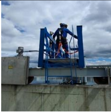
Mantenimiento preventivo en puentes decantadores secundarios
