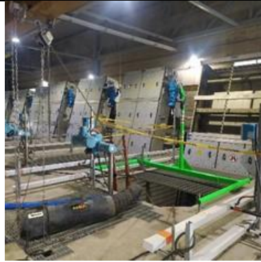
Instalación de elementos para trabajo de alto riesgo
