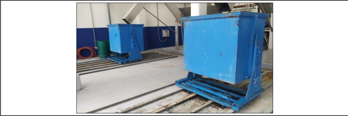
Fotografía 7. Residuos de pretratamiento provenientes del descargue de contenedores del material cribado resultante de Gruesos y Finos.
