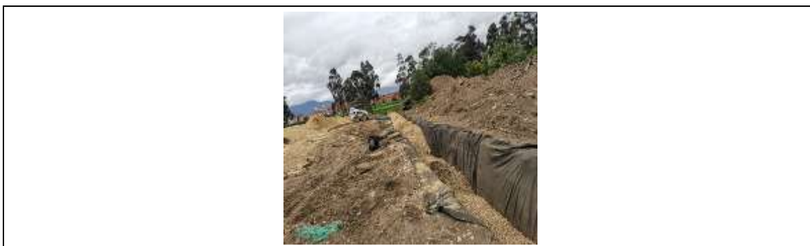
Fotografía 2. Suministro de Grava 1 ½"
