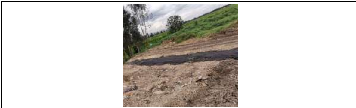
Fotografía 3. Adecuación drenaje celda 4
