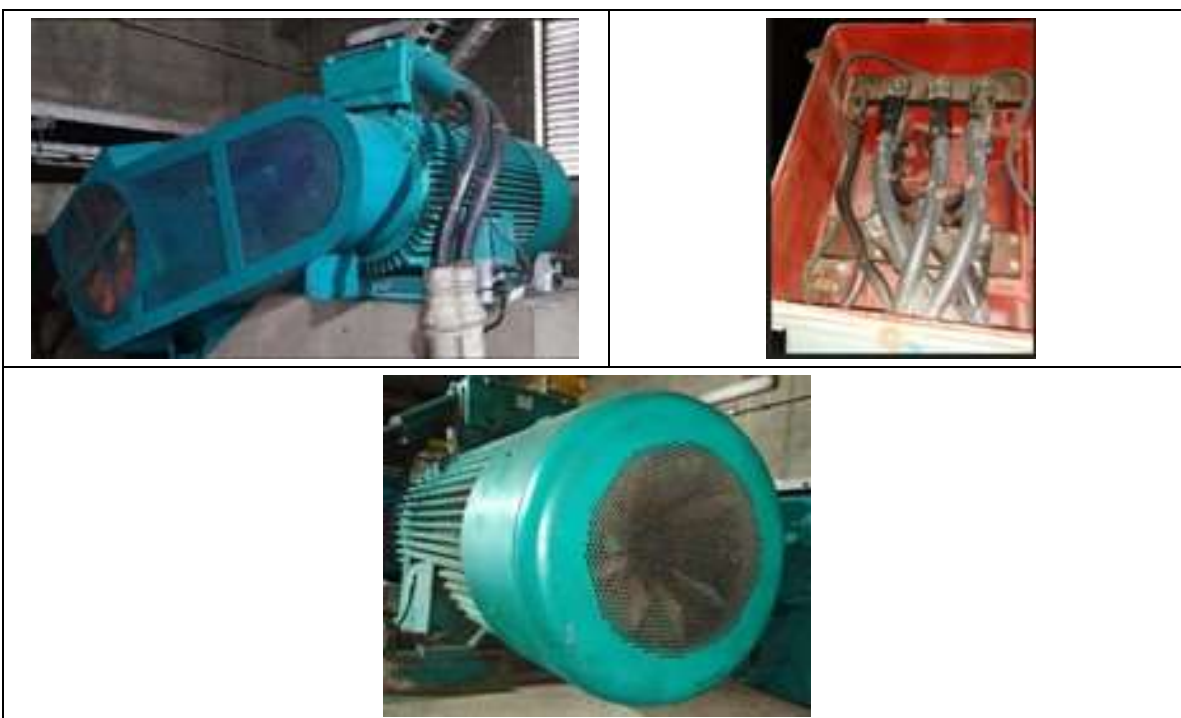
Fotografía 14. Reparación Tornillo A
