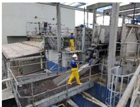
Verificación frente al uso de los EPP, área de pretratamiento
