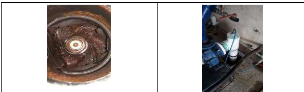
Fotografía 11. Mantenimiento Bomba 14P01C
