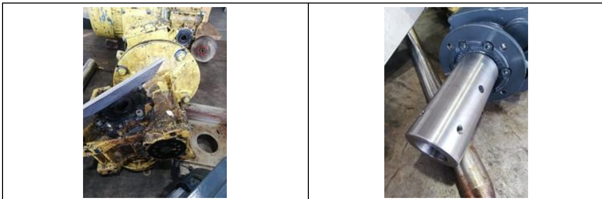
Fotografía 1. Instalación moto reductor del preparador de polímero 074QP202B
