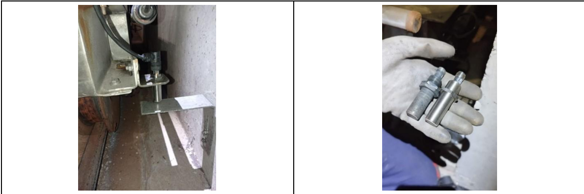
Fotografía 6. Mantenimiento sensor inductivo avancé puente desarenado-desengrasado 54.1
