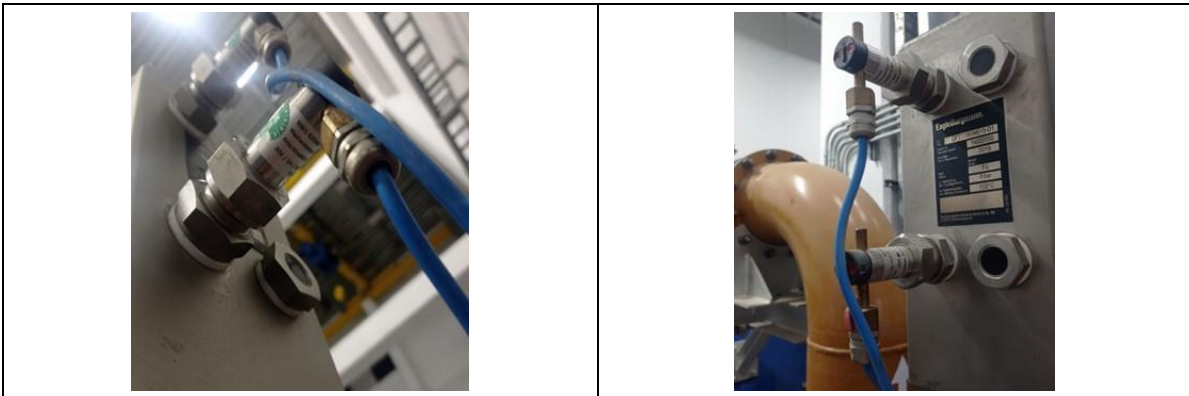
Fotografía 4. Mantenimiento interruptor de nivel en bomba WAS 065LSH102A/C
