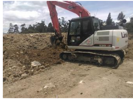
Labores de mezcla Aprovechamiento predio la Magdalena celda 5, metodología 3:1
