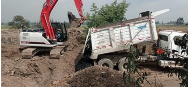
Descargue de biosólido en celda 5 Magdalena, metodología 3:1
