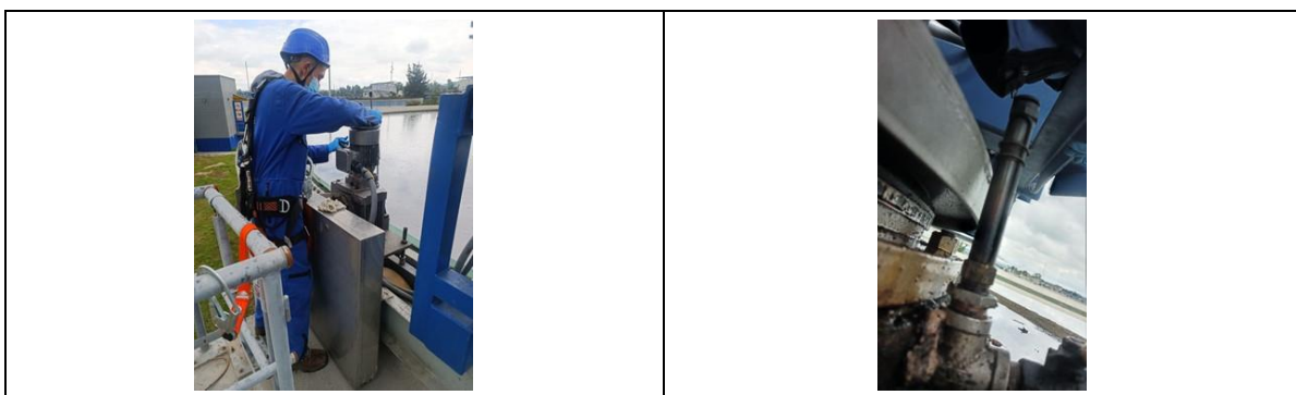
Fotografía 10. Mantenimiento cambio de aceite puente clarificador primario 057DCL001A
