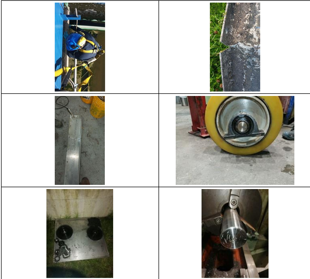
Fotografía 11. Mantenimiento clarificadores secundarios 064DCL001C y 064DCL001J
