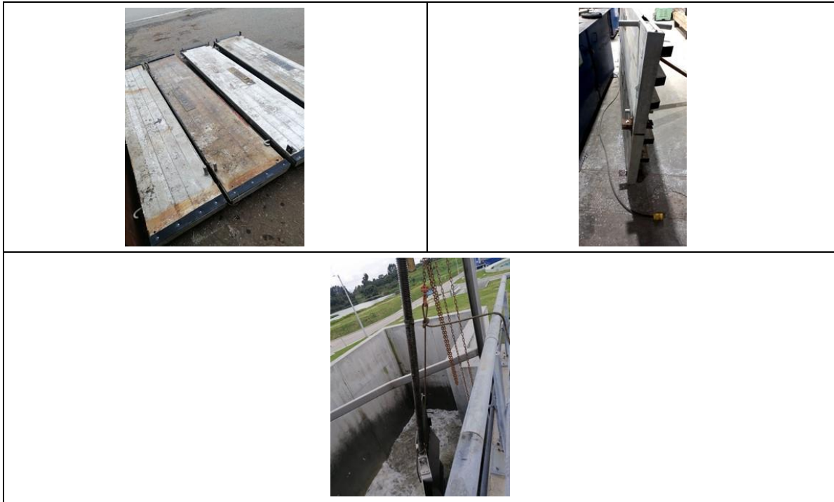
Fotografía 9. compuertas stop log en la compuerta 085MG013B, 085MG013A
