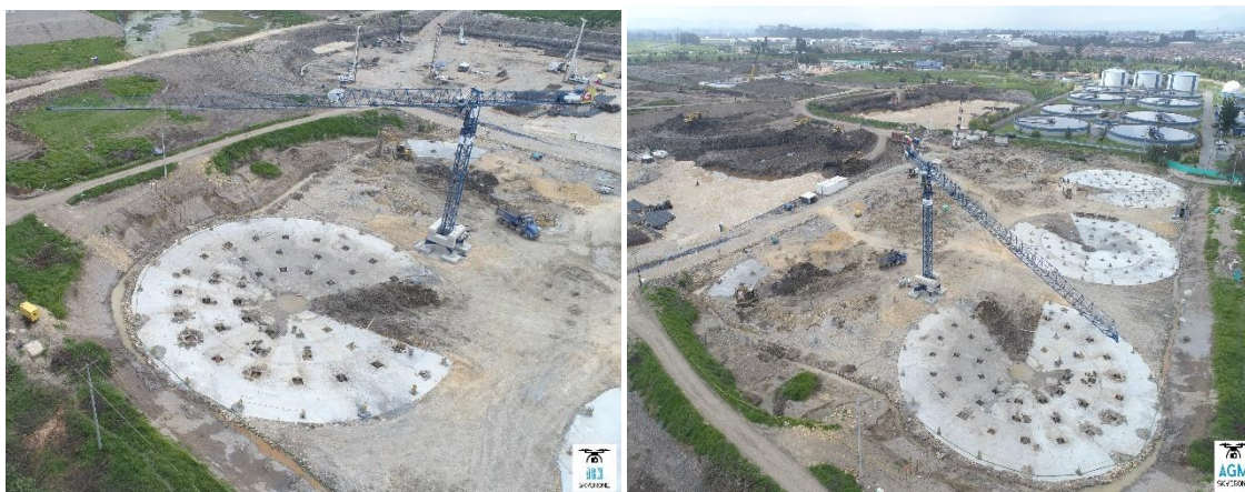
Fotos avance de obra ampliación PTAR Salitre Fase II
