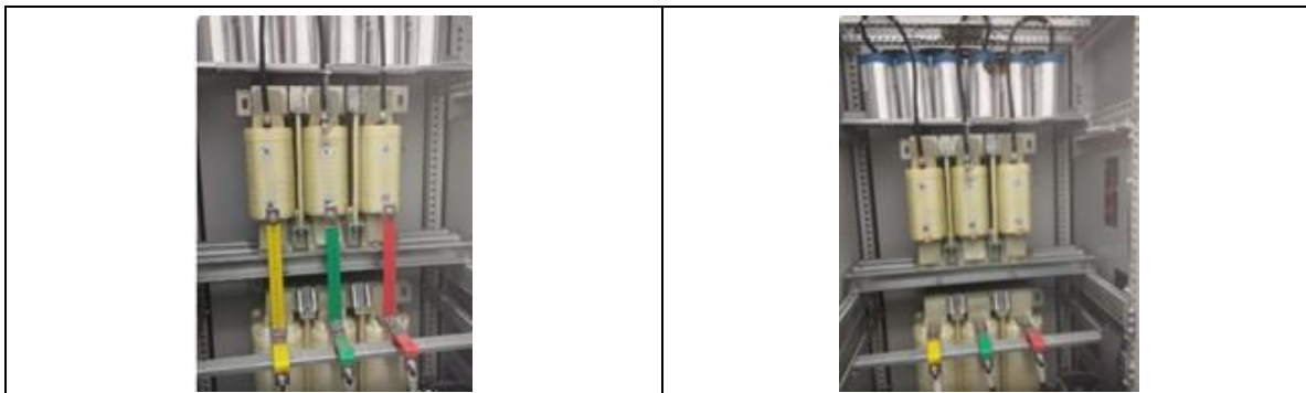
Fotografía 10. Mantenimiento variador bomba RAS estación 3 bomba 1 065VFD301A
