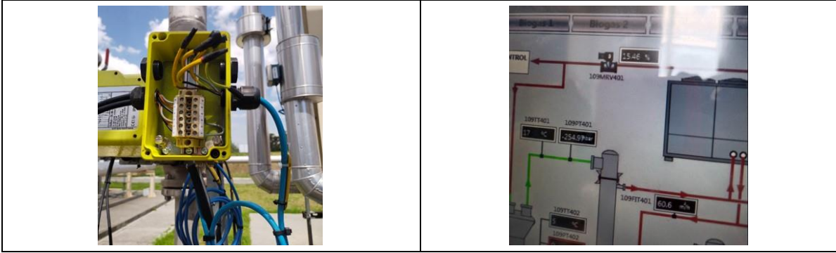
Fotografía 16. Mantenimiento válvula de recirculación 109MRV401
