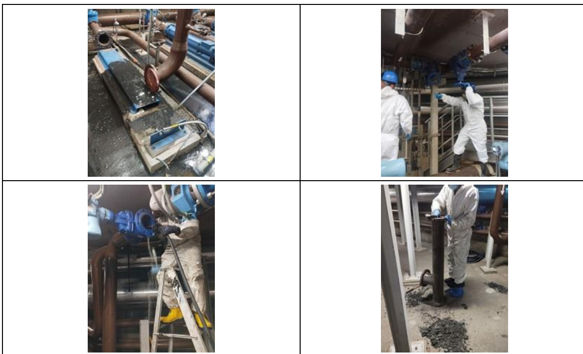
Fotografía 2. Mantenimiento línea de lodos del edificio 77 tanque de almacenamiento lodos digeridos línea 1A y 1B de centrifuga
