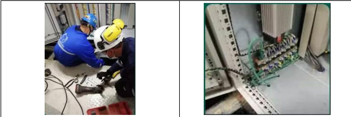
Fotografía 20. Cambio de cableado de tierras
