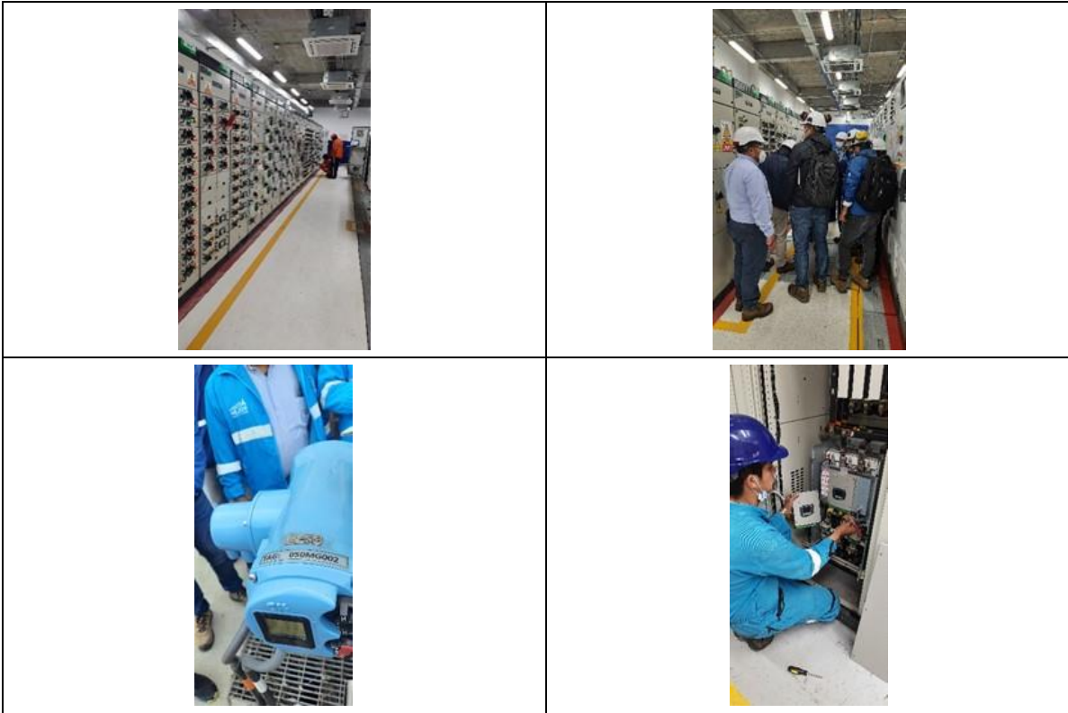
Fotografía 13. Mantenimiento generadores PTAR fase I
