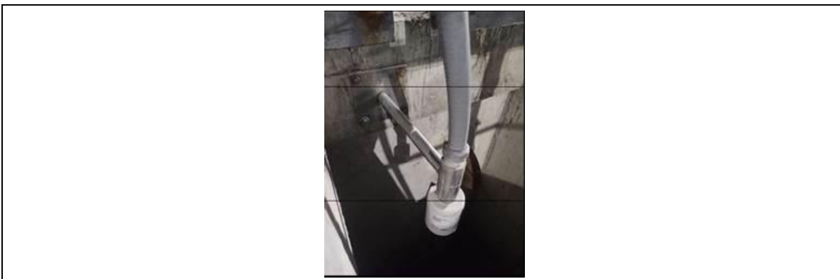
Fotografía 17. Intalacion a nivel de flotantes 58.2
