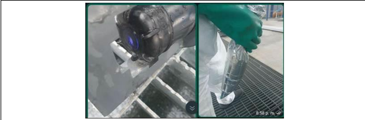
Fotografía 18. Mantenimiento sensor de oxígeno disuelto del tanque 60.1
