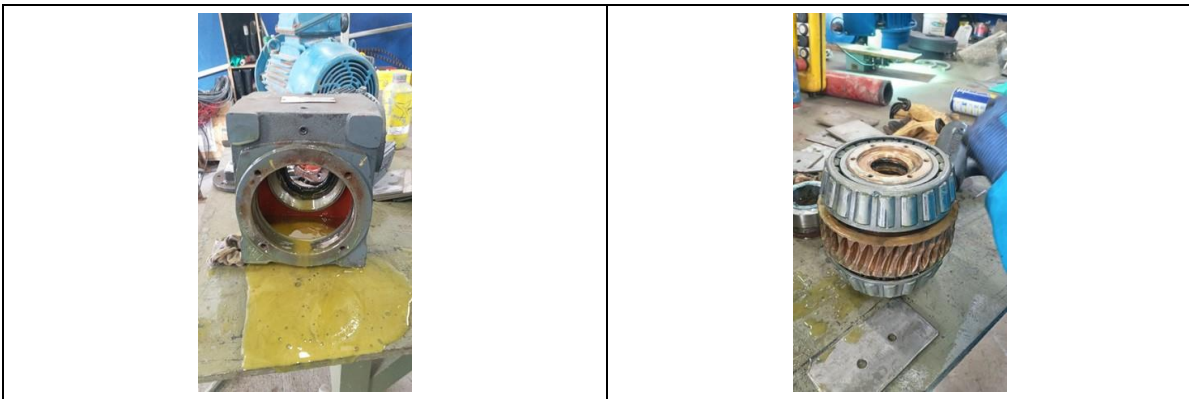
Fotografía 8. Mantenimiento motor compuerta del silo E
