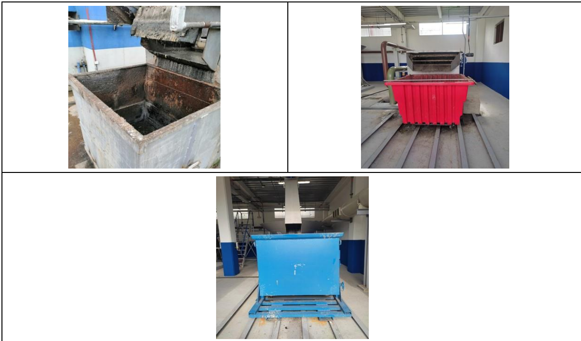
Fotografía 6. Residuos de pretratamiento provenientes del descargue de contenedores del material cribado resultante de Gruesos y Finos.
